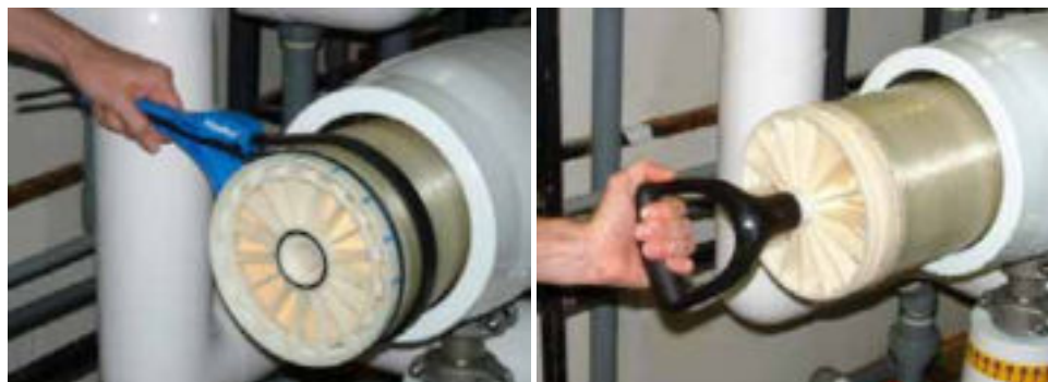
图 2. 用于端面自锁膜元件安装的轻型带钳（左）和拉手（右）
